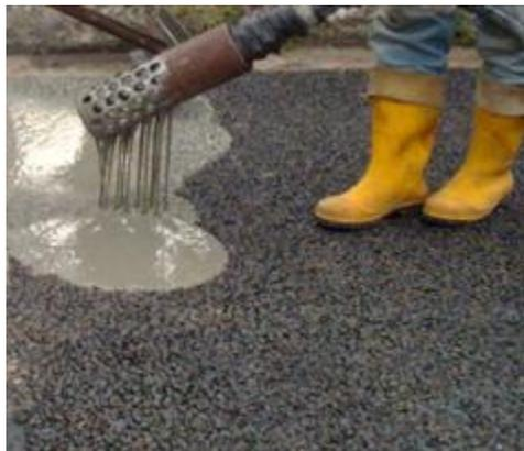
将砂浆灌入多孔沥青混凝土
