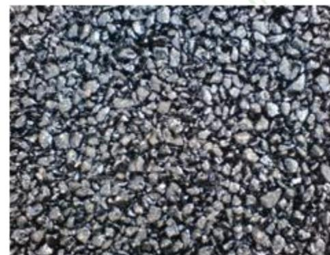
碾压后的多孔沥青混凝土表面
