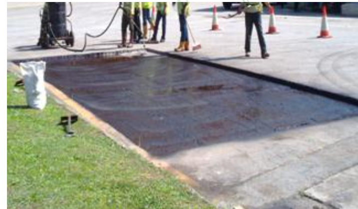
(b) Spraying Primer Coat
