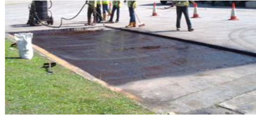
Fig. 2b Spraying primer coat
