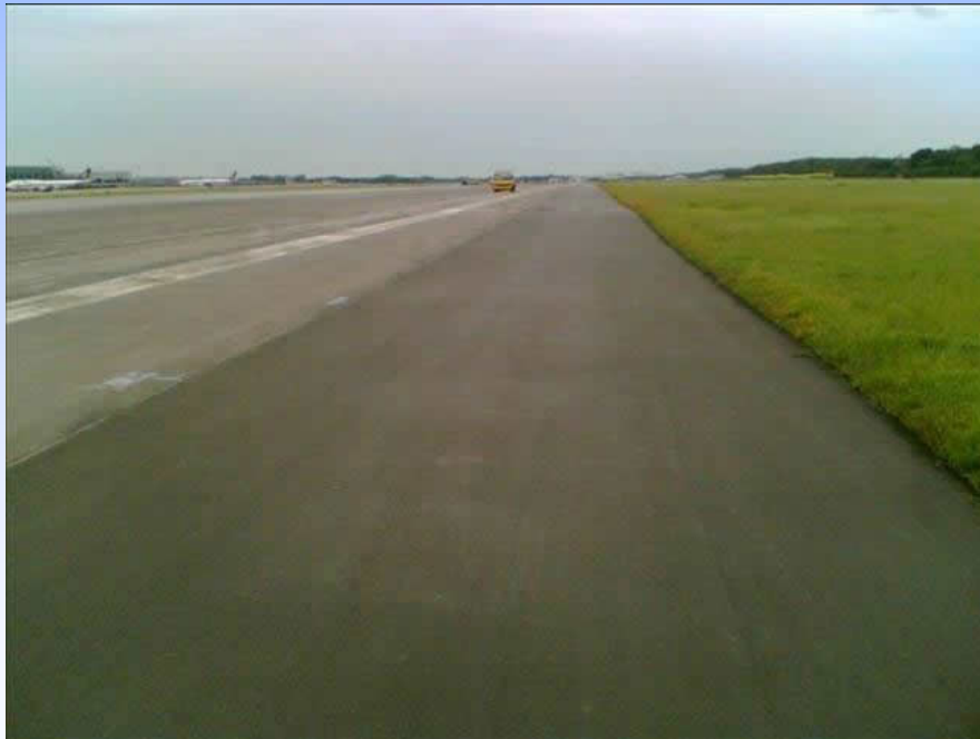
竣工3年多后的跑道I
