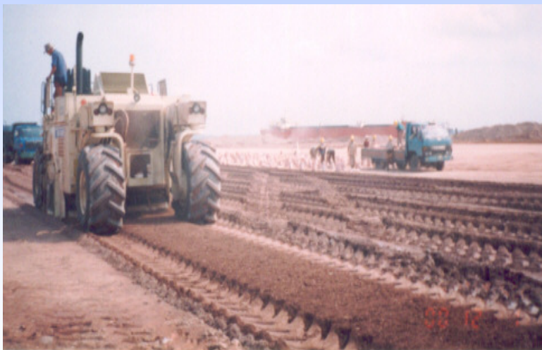
a) 人工铺撒和现场搅拌
