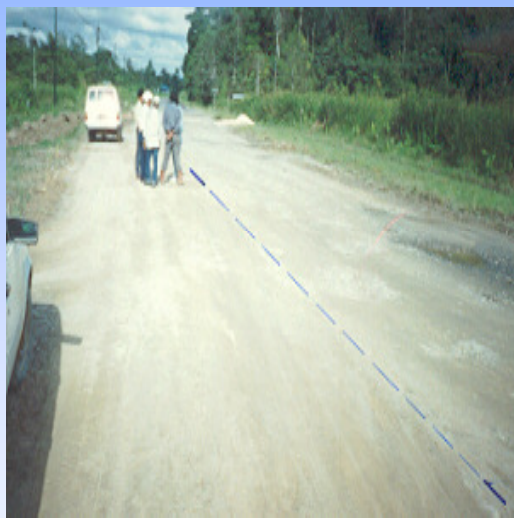
B) 加固法与常规法的效果比较 (左为加固路)
