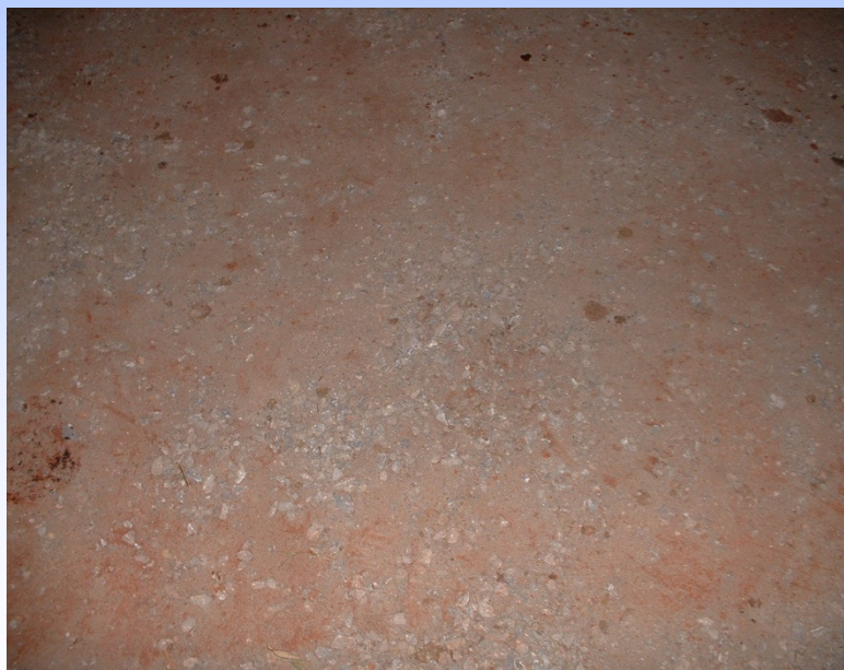
加固后的路面
