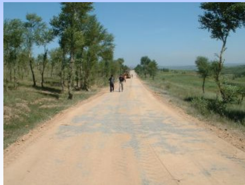
加固后的道路
