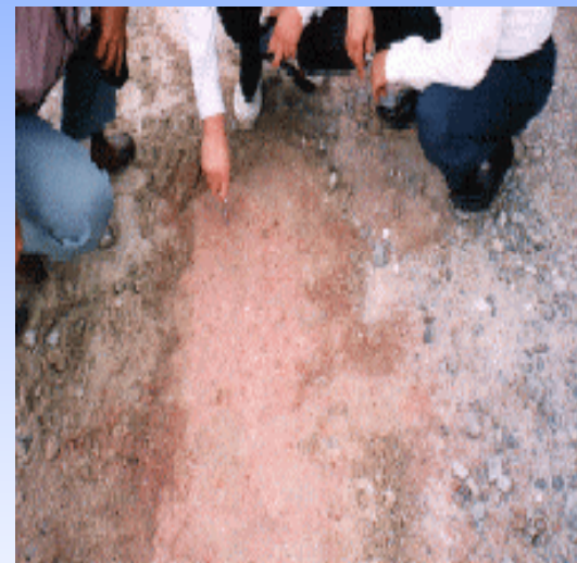
C) 未覆盖的加固路面(十年后)
