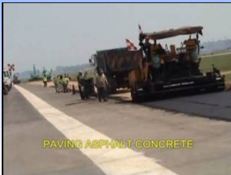
铺设沥青混凝土面层
