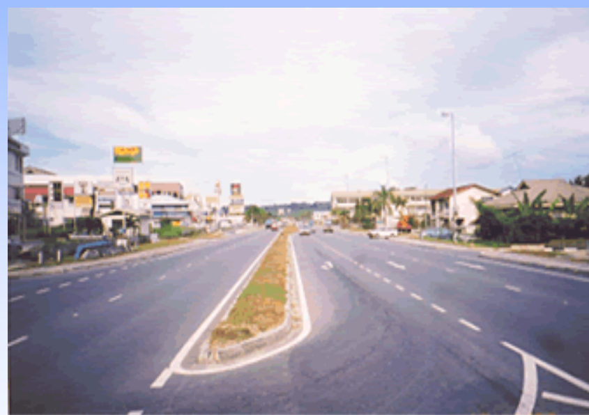
b) 完工 7 年后的道路
