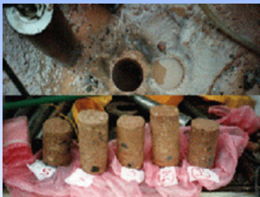
a) 加固后道路的取样
