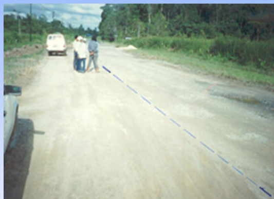
b) 加固后的道路(左半部分) 与老路的对比
