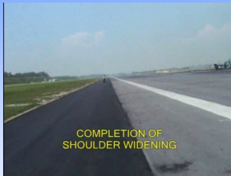
照片六：施工完成后的跑道扩宽部分
