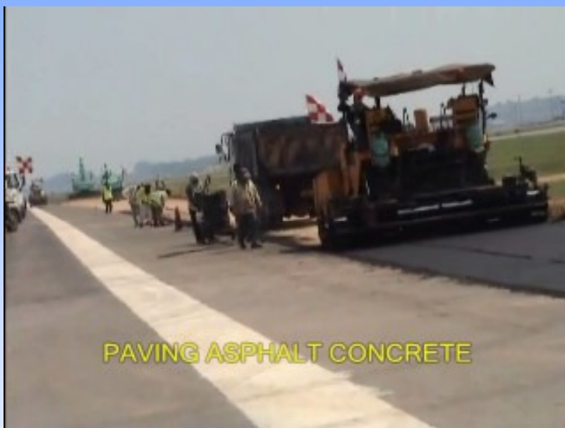
照片五：摊铺沥青混凝土
