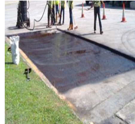
(c) Spraying Primer Coat
