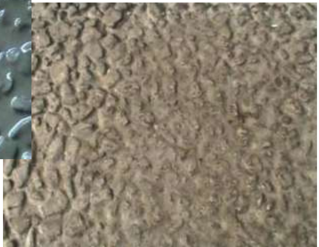
Singapore Changi International Airport Parking Apron, 2007 (A latest pavement solution) 新加坡樟宜国际机场停机坪 – 最新的半刚性路面技术, 2007年
