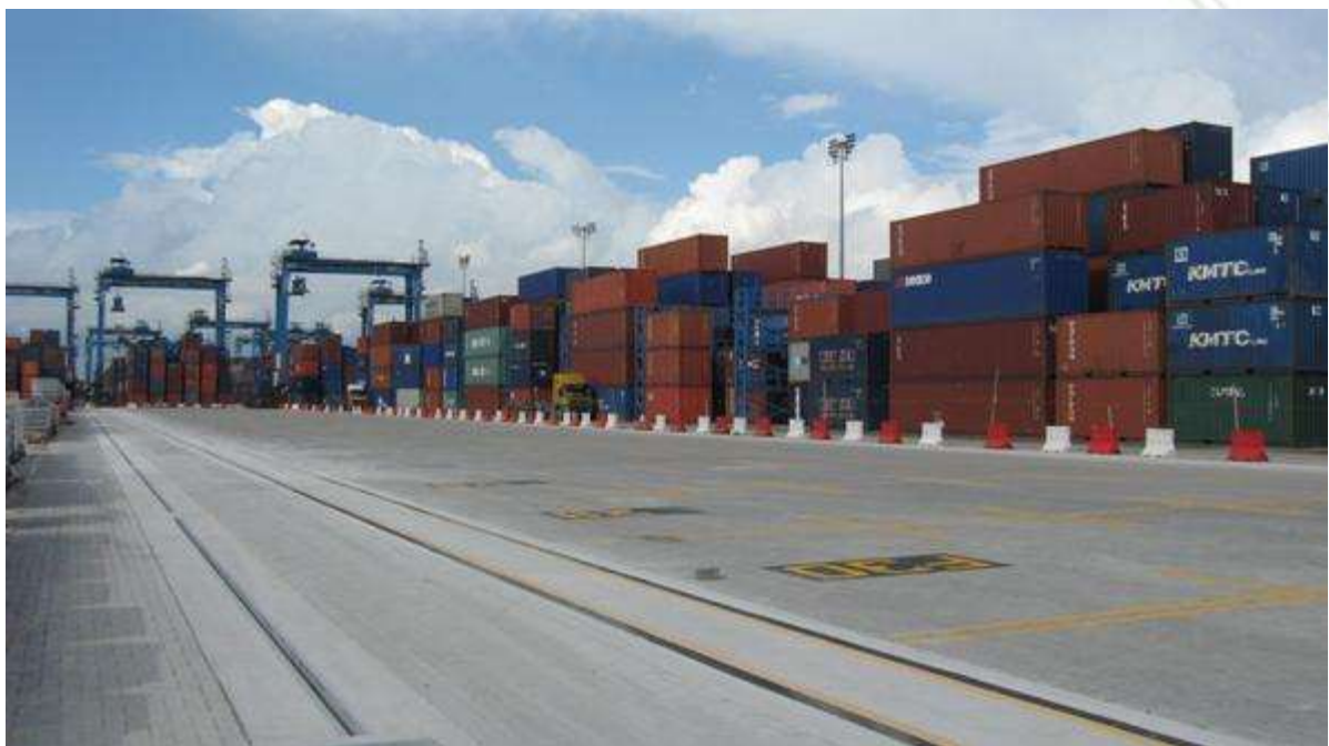
Port Klang Container Yard, Malaysia, 2010 (A typical “3R” project) 马来西亚巴生海港集装箱堆场 – 典型的“3R”工程， 2010年
