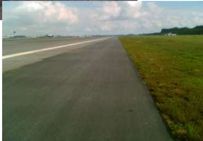
Singapore Changi International Airport Runways Widening, 2005 新加坡樟宜国际机场跑道扩宽工程, 2005年
